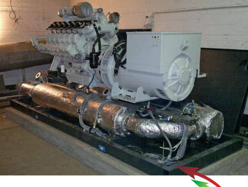
es nutzt die bei der Stromerzeugung entstehende Abwärme für die Heizung und Warmwasserbereitung." Zum Vergleich: Der durchschnittliche Wirkungsgrad eines konventionellen Kraftwerks liegt bei circa 38 Prozent, über 60 Prozent der eingesetzten Energie wird in der Regel als Abwärme ungenutzt an die Umwelt abgegeben. Darüber hinaus ist das Abgas des gasbetriebenen BHKWs besonders sauber, da es über einen 3-Wege-Katalysator gereinigt wird.
